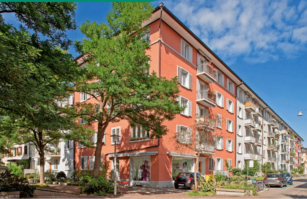
Blick ins innerstädtische Zürcher Rotachquartier, das die Baugenossenschaft Rotach teilsaniert hat
